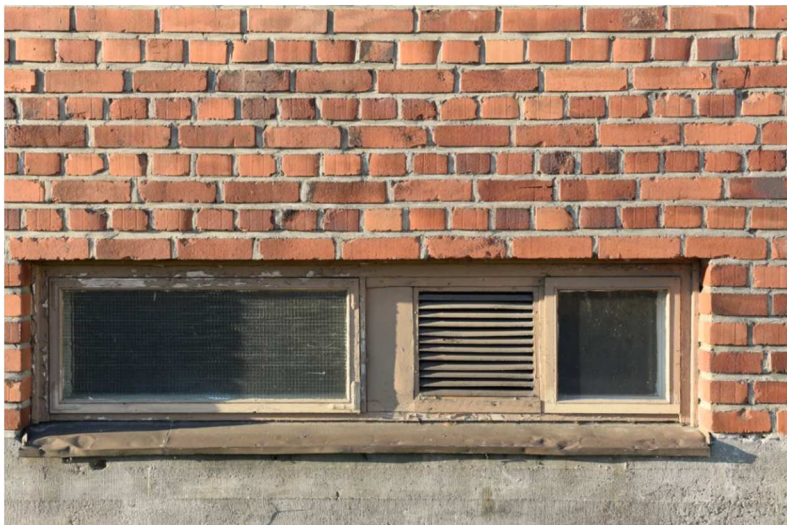
Kuva: Vanhassa osassa julkisivumuuraus on tehty ristilimityksellä, laajennussiivissä on käytetty juoksulimitystä.
