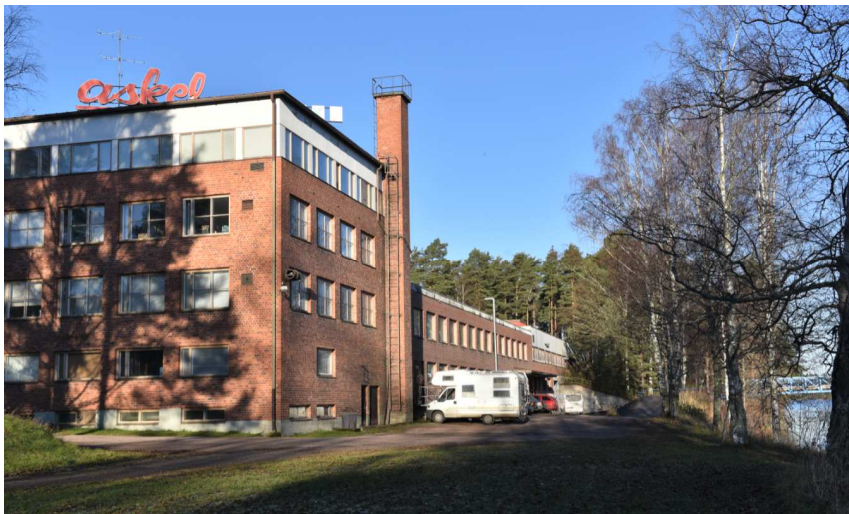
Kuva: Vanhan tehdaspuolen (A) katolla säilynyt (ei alkuperäinen) tehtaan nimikyyltti "Askel" on olennainen osa tehtaan ulkoarkkitehtuuria. Kaupparekisterin mukaan tehtaan päätoiminimenä oli Mäntyniemen Kenkätehdas 1954–88, ja Askel Oy marraskuusta 1988 lähtien.
