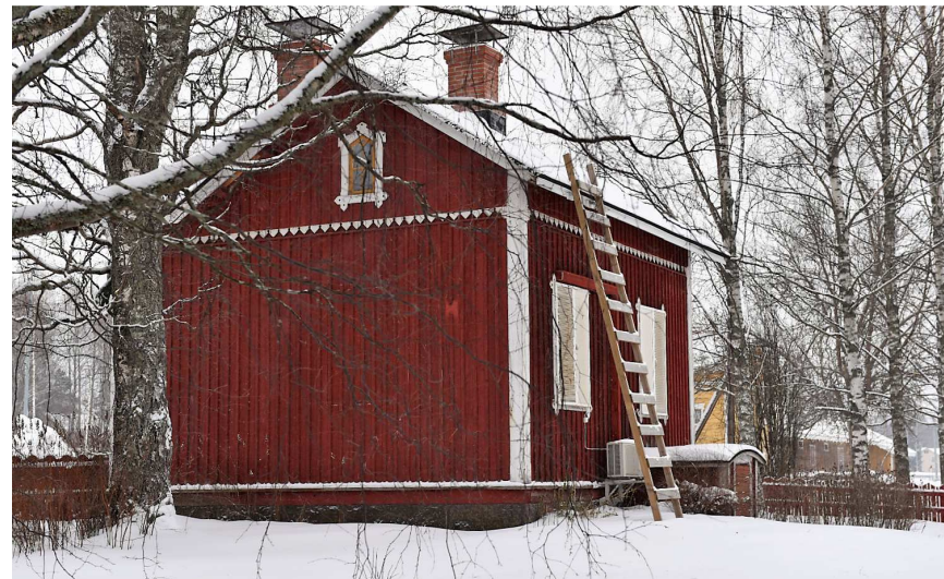
Kuva: Vahtituvan pihan puoleisissa ikkunoissa on suojaluukut.
