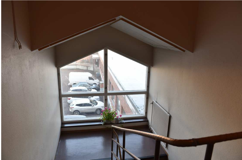
Kuva: Porrastyyppi on kaksivartinen ja lepotasollinen. Syöksyt ovat suorat, askelmat maalattua betonia. Kaikki porraskaiteet johteineen on tehty pyöröraudasta ja rautaputkista.
