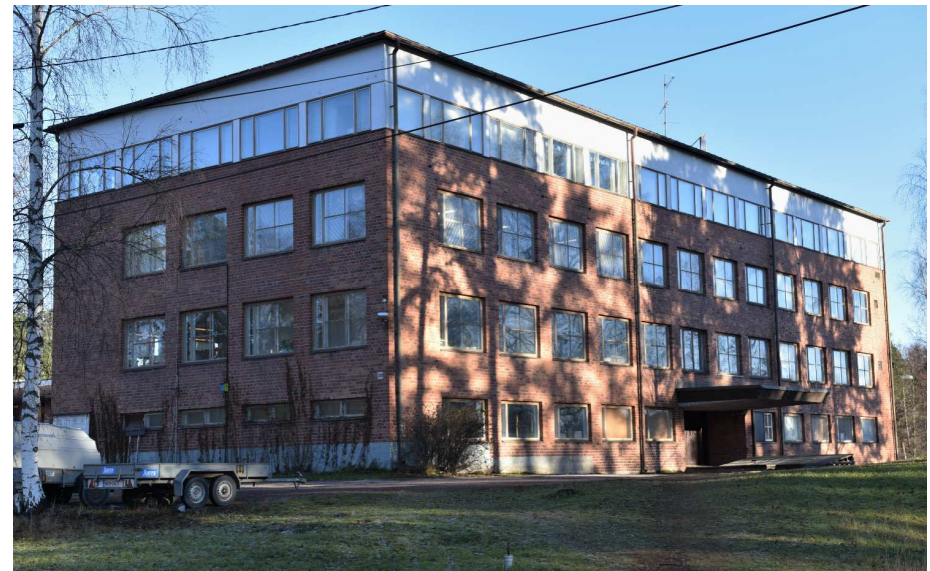
Kuva: Vanhan puolen (A) länsipääty ja eteläsivu. Rakennuksen tiiliseinät ovat ehjiä, laajoja paikkausmuurauksia ei ole tarvinnut tehdä.
