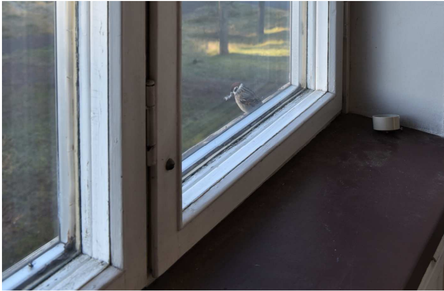
Kuva: 1960-luvulla rakennetussa IV-kerroksessa on vanhat kolmilasiset ikkunat. Ikkunapenkki on betonia ja maalattu.
