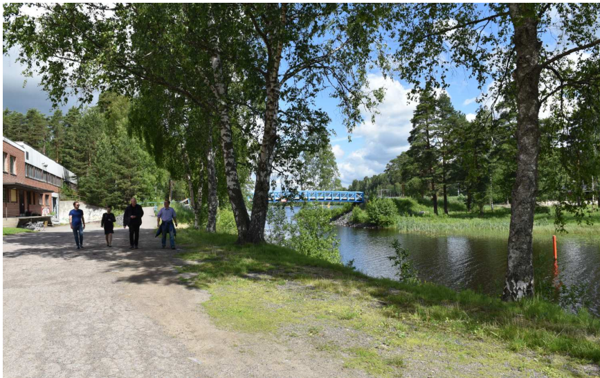
Kuva: Länsiranta, tehtaan edustalla, on pengerretty, kun pihaa on tasattu ja korotettu täytemaalla. Rautasilta johtaa salmen yli Kurkiniemen uimarannalle ja sieltä rautatieasemalle. Veneväylä sillan alitse lahdelmaan on viitoitettu.
