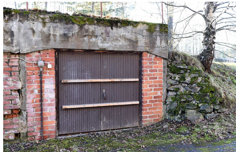
Kuva: Kenkätehtaan liimavarasto/kellari. Runko ja holvattu sisäkatto betonia, julkisivu punatiiltä. Piirustukset allekirjoittanut K. Sirkiä Mäntyharjussa 8.6.1964. MKA.
