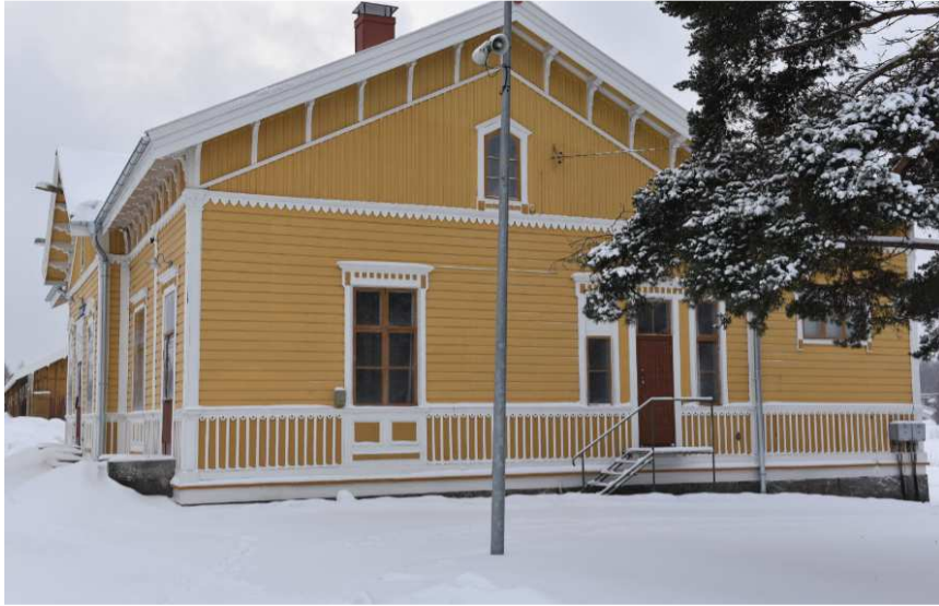
Kuva: Aseman pohjoispääty, johon 1907 avattiin matkatavarasäilön sisäänkäynti ja rakennettiin lisäsiipi.
