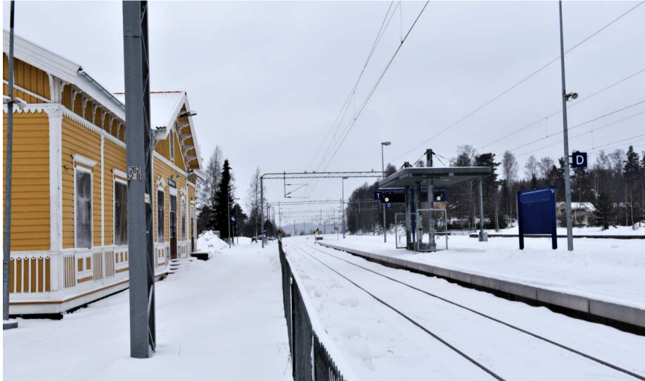
Kuva: Mäntyharjun asemarakennus ja verkkoaidan rajaama ratapiha. Odotustilana toimii laiturin avokatos.
