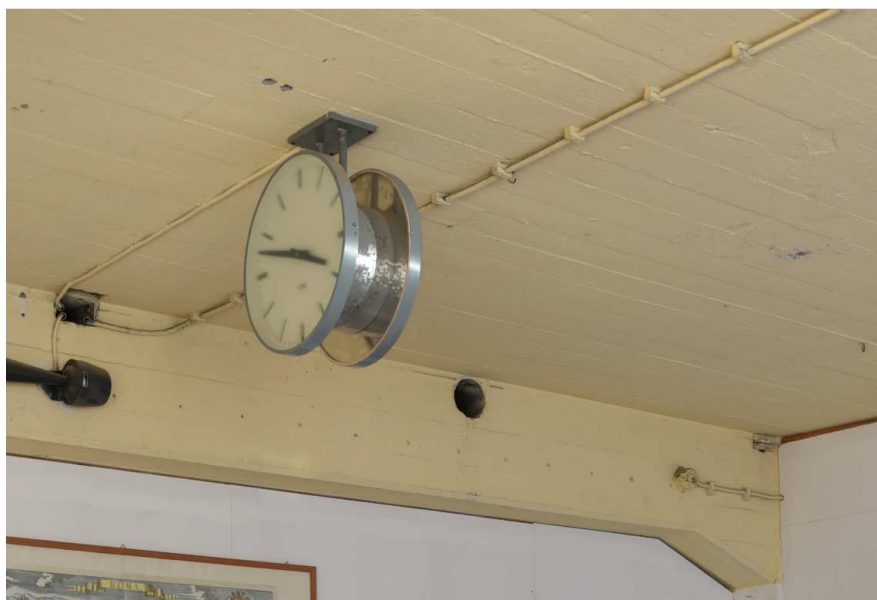
Kuva: II-kerroksen tehdassalin kello ja palkissa bakeliittinen sumneri.
