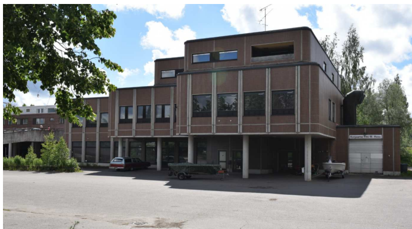
Kuva: Säästöpankin pohjakerroksessa oli tavaratalo, aulakahvio ja pankin arkisto, I-kerroksessa pankki ja yksi myymälähuone. Yläkerrassa oli sosiaalityttilat sekä kerho- ja saunatilat. Kerrokset ovat pinta-alaltaan ja pohjaratkaisultaan erilaiset, mutta jokaisessa kerroksessa on keskusaula. Julkisivuissa on keraaminen laattaverhous.
