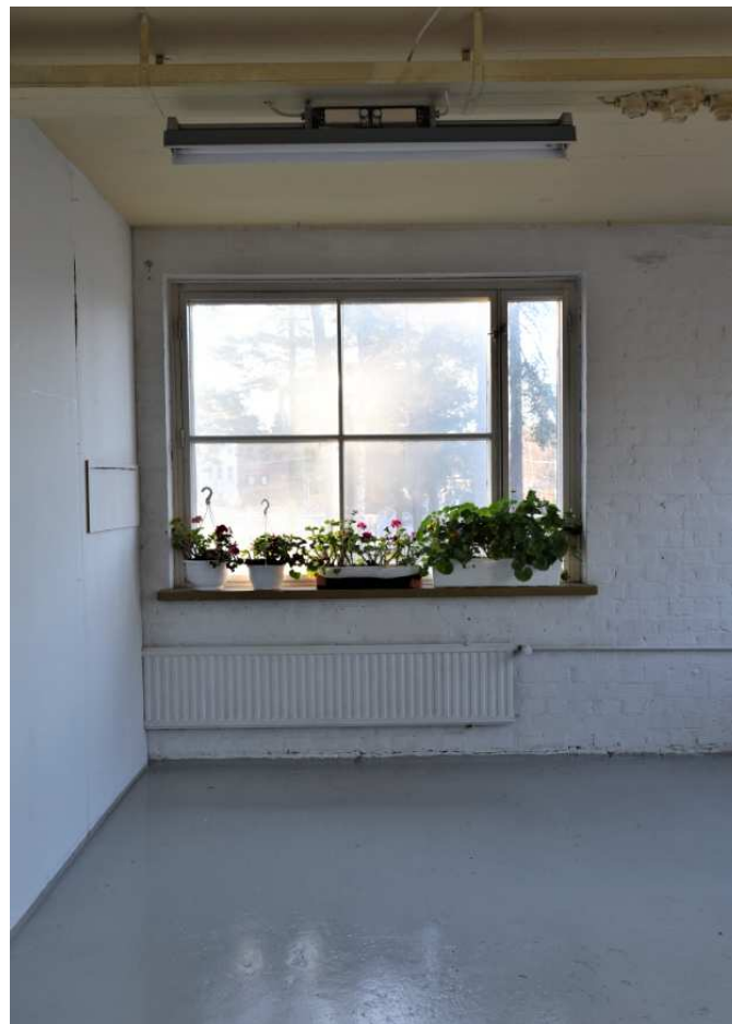
Kuva: II-kerroksen työhuone, joka on erotettu isosta tilasta kevyillä väliseinillä. Ulkoseinä on kevyesti rapattua ja maalattua tiiliseinää. Isot ikkunat ovat tyyppisiä tehdasrakennuksille. Vanhaa ilmettä on saatu jakamalla karmijaoltaan tyyppillinen 50-luvun ikkuna kapeilla pienoilla neljään ruutuun.
