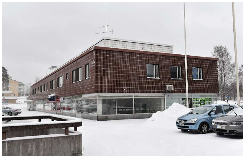
Kuva: Kiinteistö Oy Säästökulman (1965) pitkä tasakattoinen rakennus rajaa hallinto- ja liikekorttelin sisäpihaa etelässä. Julkisivut jäsentyvät vaakasuuntaisesti liiketilojen yhtenäiseen näyteikkunaan, keskiosan ruskeaan klinkkeriseinään ja valkoisin klinkkereihin verhoiltuun kattokerrokseen. Itäpäädyssä on matala laajennussiipi.
