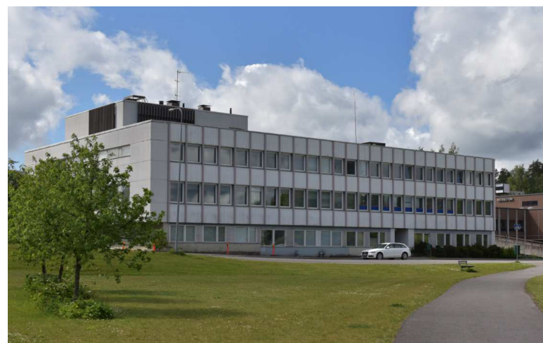
Kuva 2017: Pohjakerroksen liiketilojen lasiseinät on korvattu pienemmillä puiikkunoilla. Kulmalla ollut sisäänveto on poistettu, samoin sisäänkäynnit yhtä lukuun ottamatta. Sokkelista on poistettu klinkkeriverhous. Muutokset eivät ole tue rakennuksen alkuperäistä, horisontaalisuutta korostavaa julkisivujäsentelyä, jossa tumma tai sisäänvedetty alakerros visuaalisesti irrotti vaalean rakennuksen maasta.
