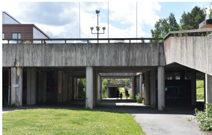
Kuva: Betonista yläkantta jatkettiin 1980-luvulla uuden säästöpankin rakentamisen yhteydessä. Kuvassa näkyy myös alikulkukäytävä, joka vie kantatien ali liikekeskustaan.
