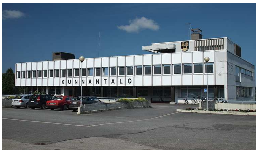
Kuva 2017: Syvennykseen on vaihdettu puitejaoltaan alkuperäisistä poikkeavat ikkunat. II-kerroksen metalliset ikkunapuitteet ovat paksummat kuin alkuperäisissä ikkunoissa, ja tämä on muuttanut hieman julkisivujen struktuuria. Alkuperäiseen suunnitelmaan kuulunut betoniseinäinen kioski on purettu. Päädyn I-kerroksen ikkunat on suurennettu,
