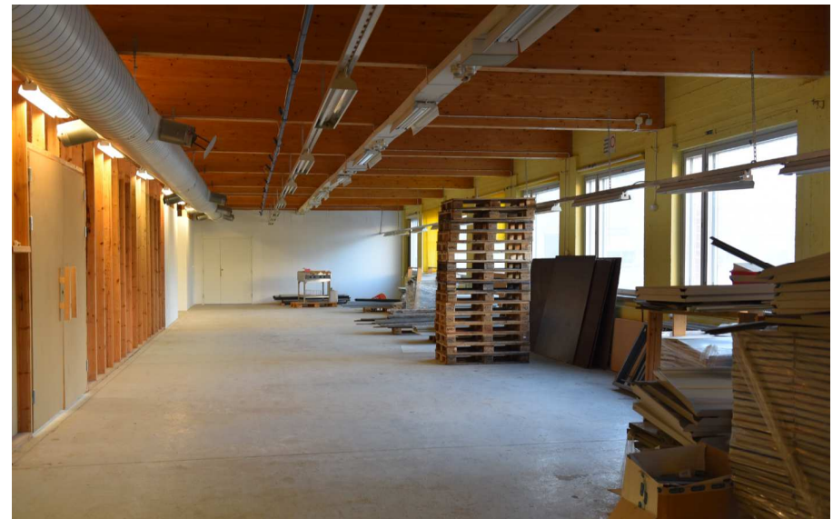
Kuva: B-osan yläkerroksen tuotantohalli.
